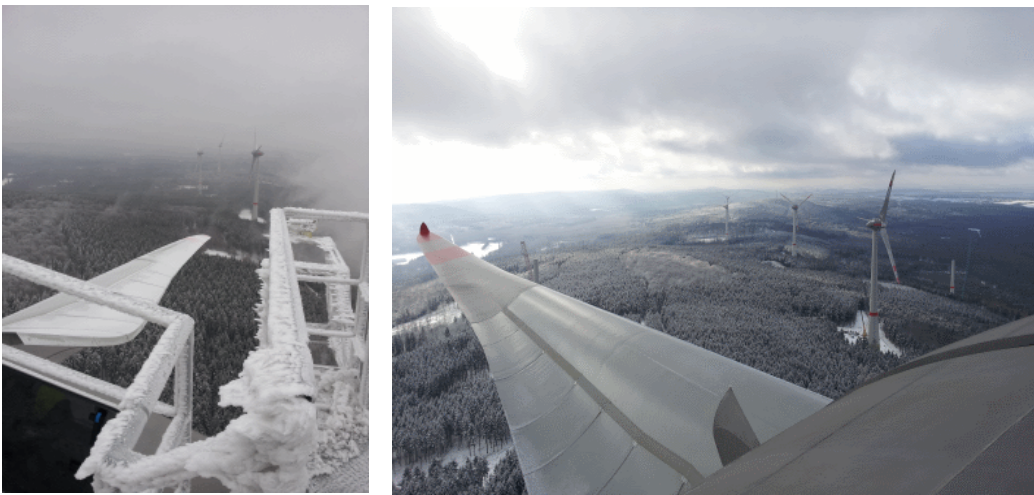
Vereiste Windenergieanlagen (li) verursachen hohe Kosten. © VERBUND Windenergieanlagen ohne Eis (re). © VERBUND
